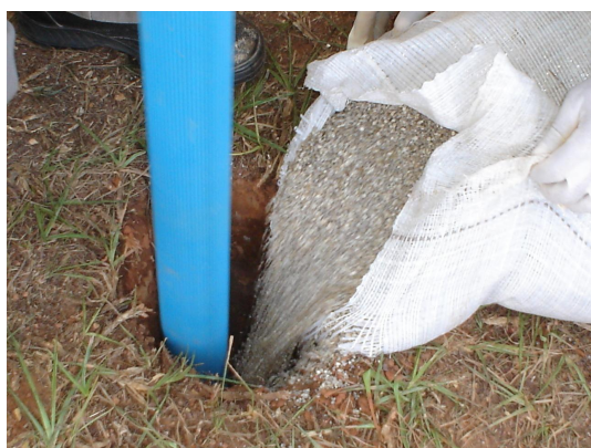
Foto 03 – Colocação de pré-filtro no poço
