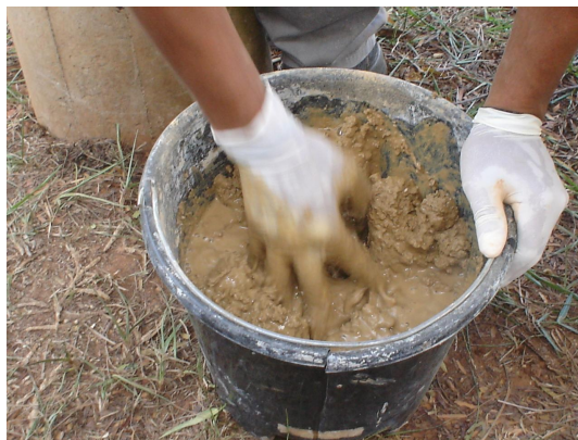
Foto 04 – Preparação do selo de bentonita
