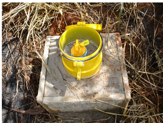
Foto 06 – Poço protegido por cap expansível e lacre KW Ambiental
