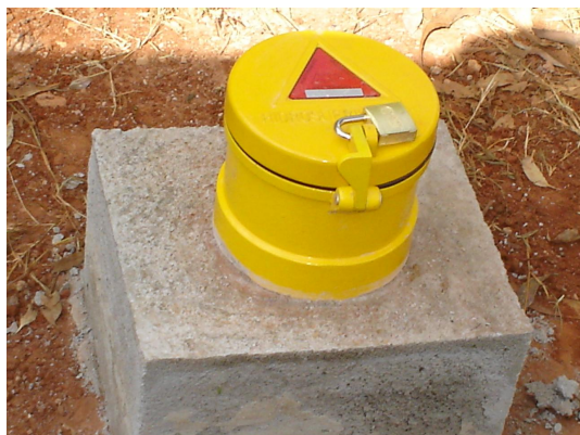
Foto 05 – Proteção externa do poço
