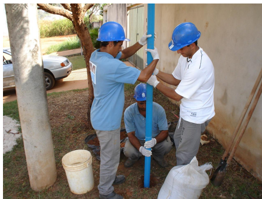
Foto 02 – Revestimento do poço com tubo geomecânico
